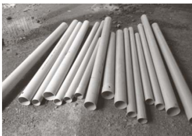
شکل (۲) لوله‌های PVC جهت حفاری شمع‌ها
