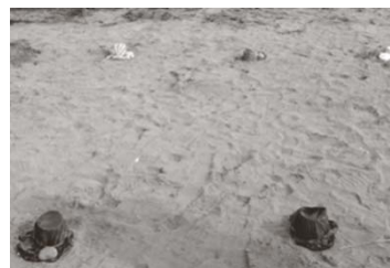
شکل (۳) نمایی از شمع‌های حفاری شده
